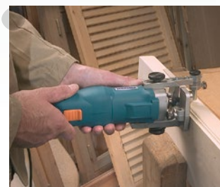
Realización de molduras.
