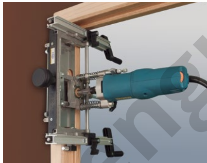
Realización del encaje superior en el marco.
