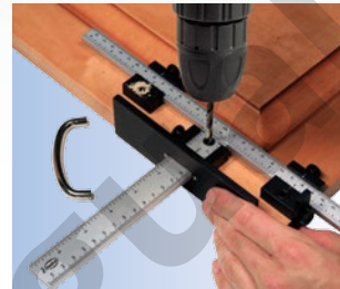
Taladrado para tiradores de puertas.
