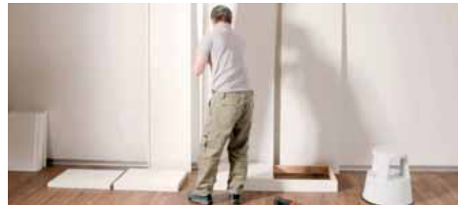
Colocar el lateral del mueble sobre el zócalo. El tornillo sobresaliente permite posicionar correcta y directamente el elemento.
