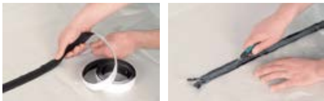
Instalación de la cremallera.
