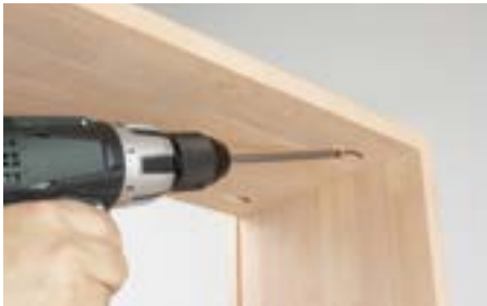
Fijación mediante tirafondo
